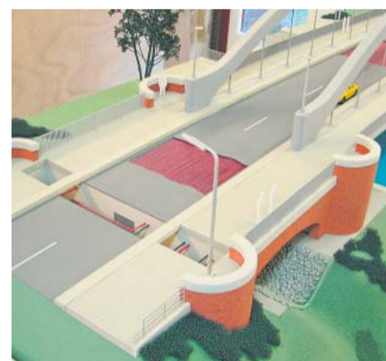
Im Modell: Zu sehen sind das Heizregister im Fahrbahnbelag und die Geozentrale mit Sammel- und Verteilerleitung. Foto Landesbetrieb Straßenbau und Verkehr Lübeck
